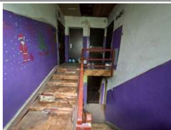
2.stāva kāpņu telpa
